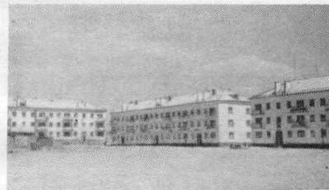
Рудный Джезказган. Поселок Железнодорожный. Фрагмент застройки квартала № 5.
