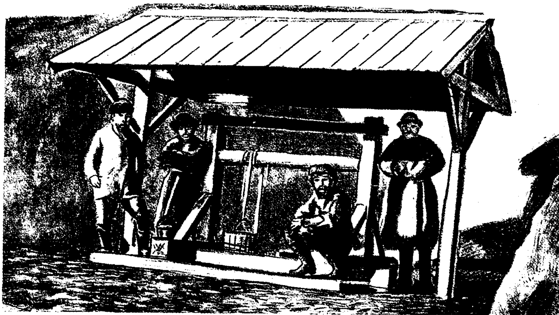
Шымқұлақ кеніндегі руданы жоғары шығаратын қол шығыры (1891).
