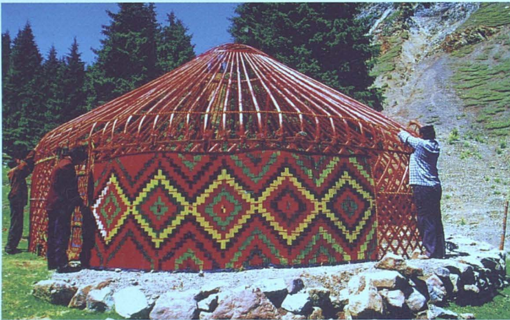
Үй қаңқасын орнықтыру, шым ши орау 毡房骨架，围席帘 Curtains surrounding the yurt
