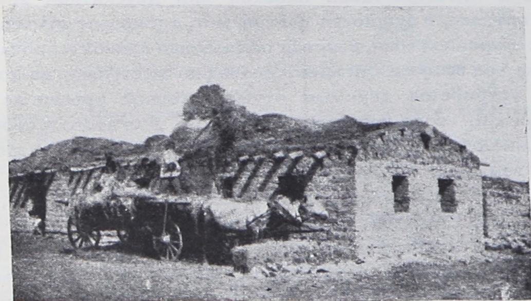
Фиг. 16. Покрытие соломой двускатной крыши. Видны сволоки и концы крокв.
