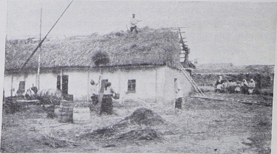
Фиг. 19. Покрытие двускатной крыши на стропилах соломой.
